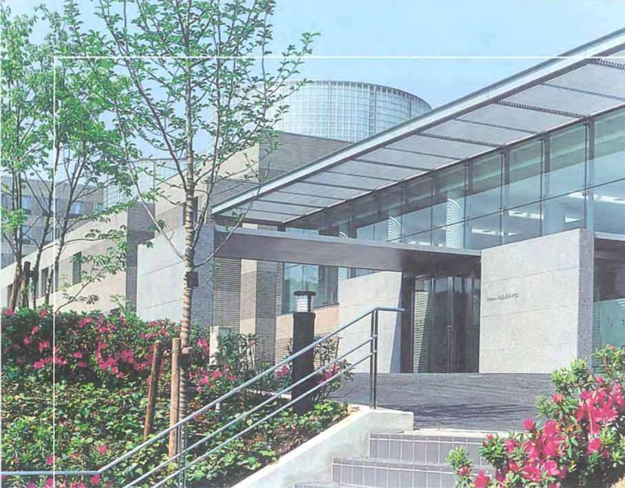
財団事務棟 エントランス
