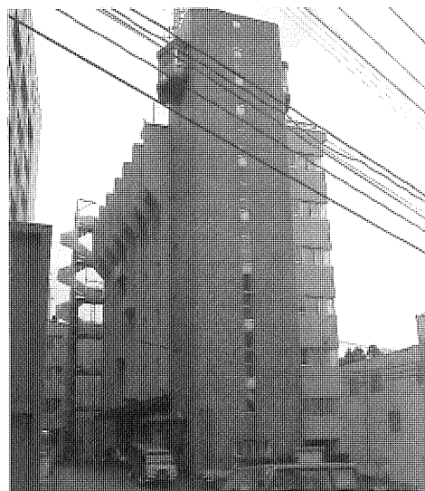
▲消防本部・盛岡中央消防署
